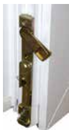
Estrarre lo scrocco per aprire la seconda anta
